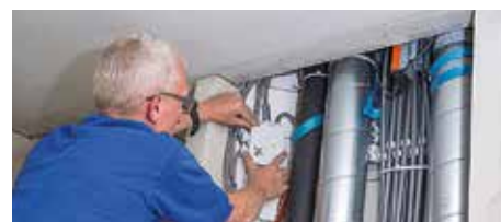
6. ...en de installaties ook in één dag! Hier de assemblage van de leidingschacht.
