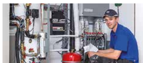
7. Verdeler voor vloerverwarming in techniekkast wordt aangesloten.
