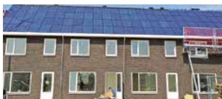
5. Binnen één dag wordt de woning bouwkundig ‘neergezet’.
