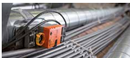
2. De leidingschacht wordt geprefabriceerd.
